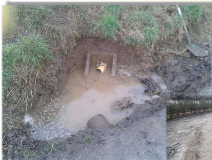
Rue Haig, à la Tourelle, une traversée de route a été réhabilitée, les fossés curés et le bas-côté empierré, le tout à la main.
