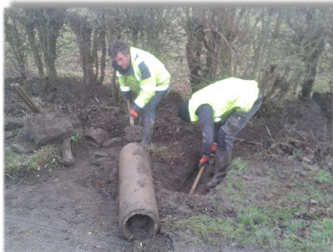
Rue Haig, à la Tourelle, une traversée de route a été réhabilitée, les fossés curés et le bas-côté empierré, le tout à la main.
