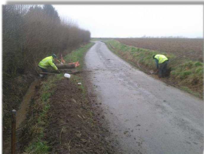
Rue Haig, à la Tourelle, une traversée de route a été réhabilitée, les fossés curés et le bas-côté empierré, le tout à la main.
