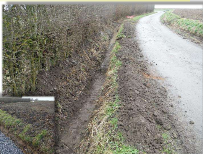
Rue Haig, à la Tourelle, une traversée de route a été réhabilitée, les fossés curés et le bas-côté empierré, le tout à la main.
